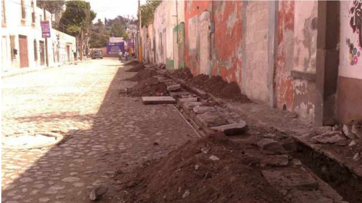
FIGURA 5. OBRAS EN XANENETLA
