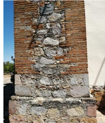
FIGURA 10: SISTEMA CONSTRUCTIVO CIMIENTO DE PIEDRA Y LADRILLO
