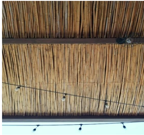
FIGURA 8. SISTEMA CONSTRUCTIVO RURAL DE TECHUMBRE CON CARRIZO EN LA PARTE INFERIOR DE UNA VIVIENDA EN COSALÁ
