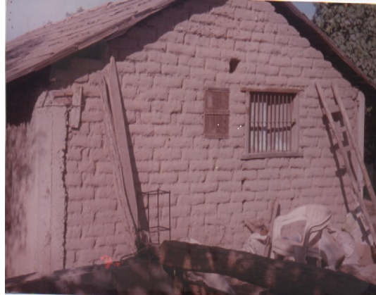
FIGURA 7: CASA HECHA DE ADOBE Y TECHO DE DOS AGUAS EN EL POTRERO DE SATAYA, NAVOLATO
