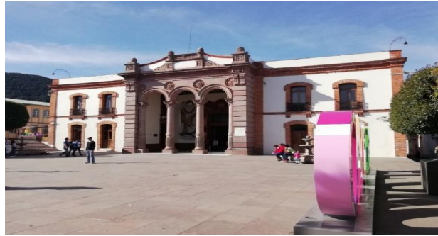
Fuente: Imagen 7. MEDIATECA INAH . Imagen 8: [Fotografía de Gerardo Sánchez]. (El Oro, Estado de México, 2019).
