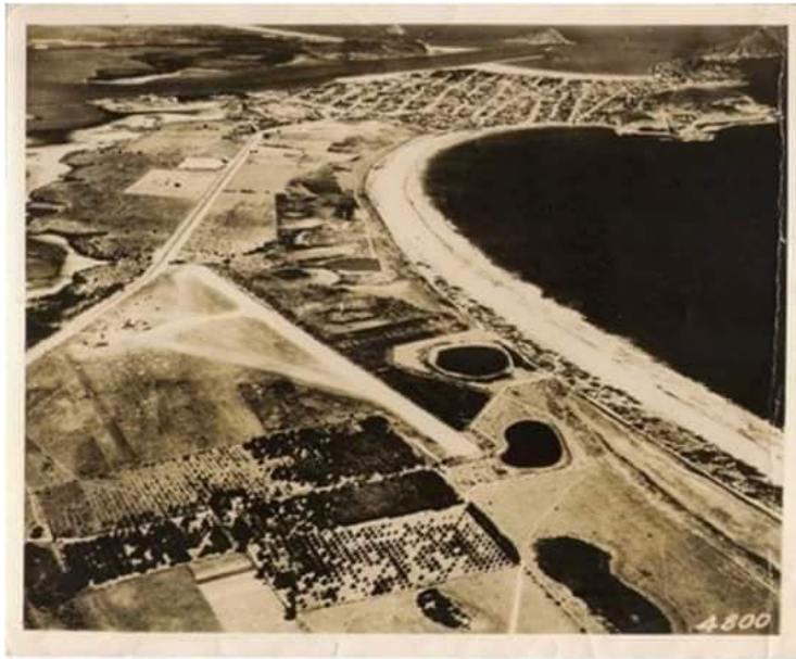
FIGURA 2. VISTA AÉREA DE LA FUTURA AVENIDA DEL MAR, A LA DERECHA, OCÉANO PACÍFICO, AL FONDO, CASCO HISTÓRICO DE MAZATLÁN.
