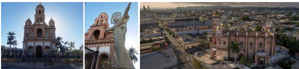
Figura 22. FACHADA PRINCIPAL, VISTA A DETALLE Y AÉREA DEL SANTUARIO EN 2023.
