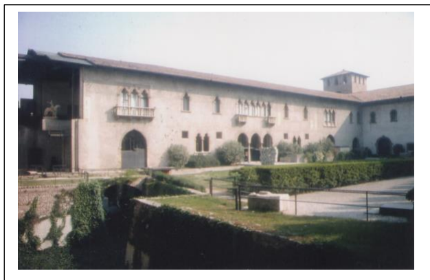
Figura 4. Intervención de Carlo Scarpa en Castelvecchio
