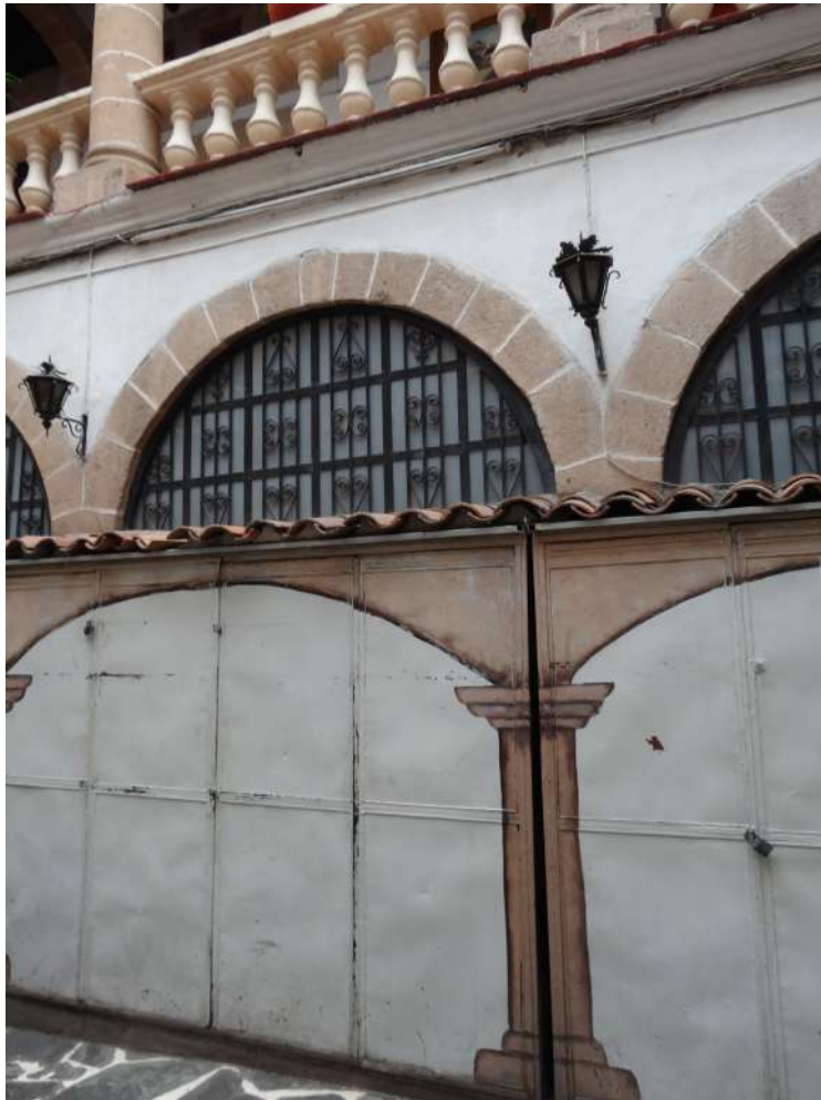
Figura 14. Sobre posición de locales comerciales, en el patio central del edificio del hotel Casa Grande.
