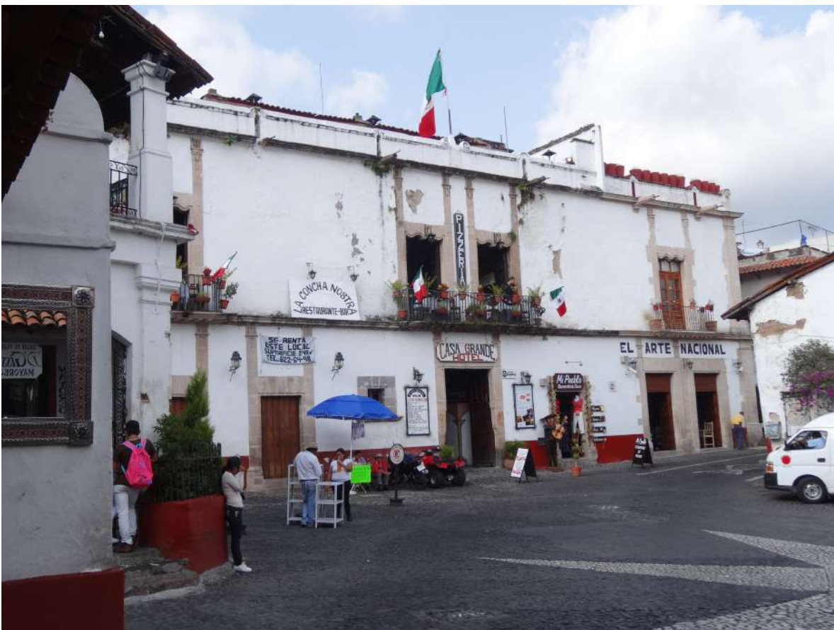
Figura 13. Fachada modificada del hotel Casa Grande
