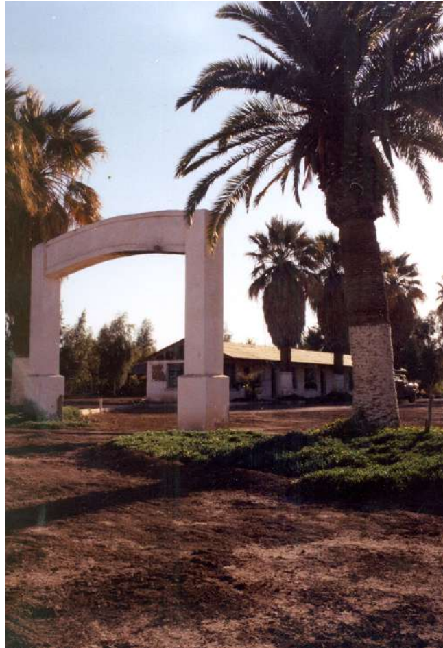
FIGURA 12. ANTIGUO ARCO DE ACCESO AL RANCHO DUARTE, DAÑADO EN EL SISMO DE 2010.
