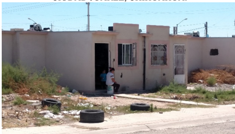
FIGURA 2. VIVIENDA ABANDONADA Y VANDALIZADA EN CIUDAD JUÁREZ, CHIHUAHUA.
