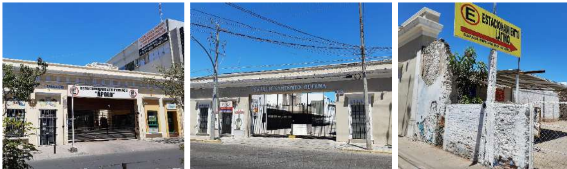
Figura 12. CONDICIONES DEL PATRIMONIO ARQUITECTÓNICO, POR CAMBIOS DE USO DEL SUELO EN EL CENTRO HISTÓRICO DE CULIACÁN
