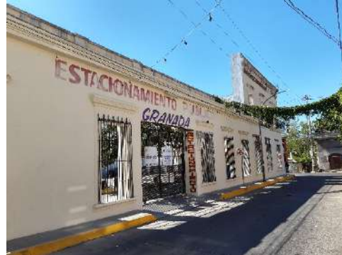
Figura 10. ESTACIONAMIENTO PÚBLICO, ANTES HOTEL GRANADA
