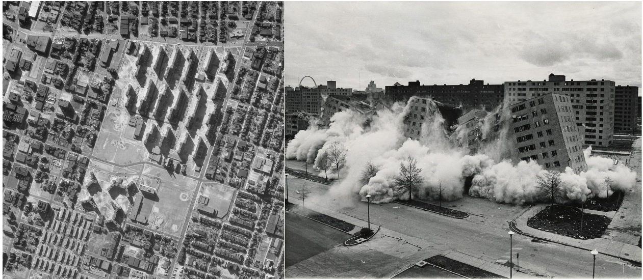
3. Conjunto y demolición de Pruitt-Igoe. 5
